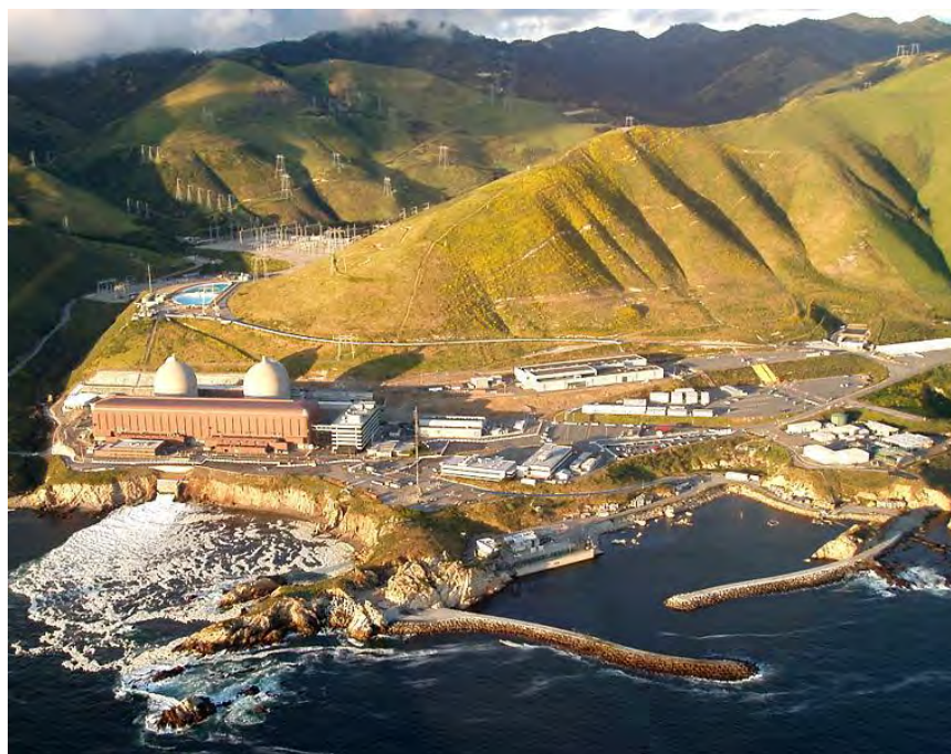
Калифорнийская АЭС в каньоне Дьявола
